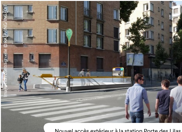
Nouvel accès extérieur à la station Porte des Lilas.
