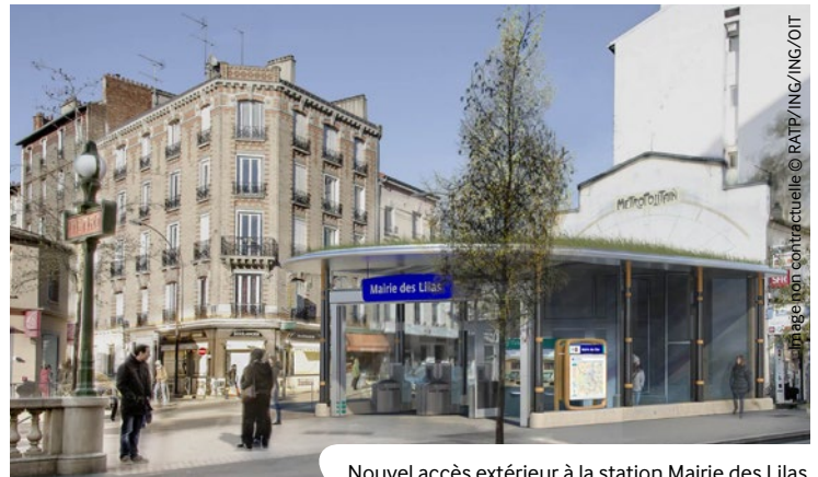
Nouvel accès extérieur à la station Mairie des Lilas.
